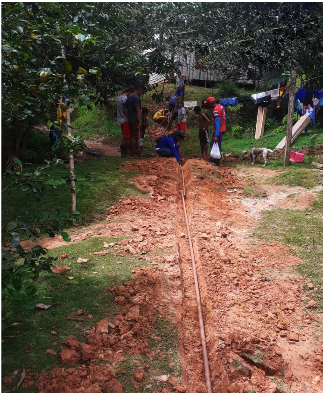
Figura 15 - Instalação do sistema de encanação Vila Soares - Uarini-AM.
