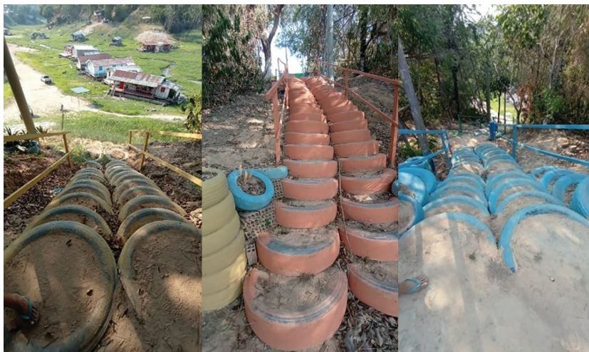
Figura 1 - Escadaria de acesso ao cemitério Nossa Senhora da Conceição das Lajes
