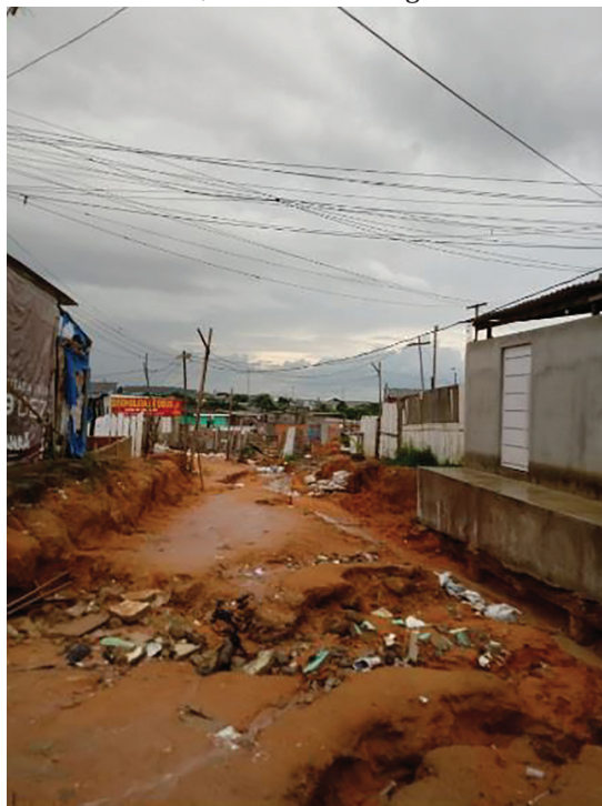
Figura 04 – Área da comunidade onde se encontrava o sítio Nova Cidade. Ruas não asfaltadas, sem rede de esgoto e coleta de lixo.
