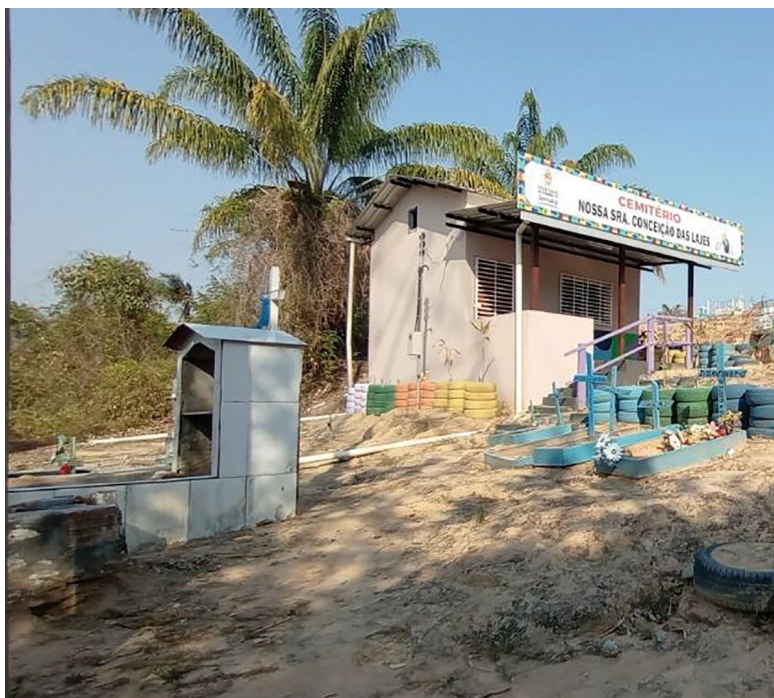
Figura 2 – Sede da administração do cemitério Nossa Senhora da Conceição das Lajes
