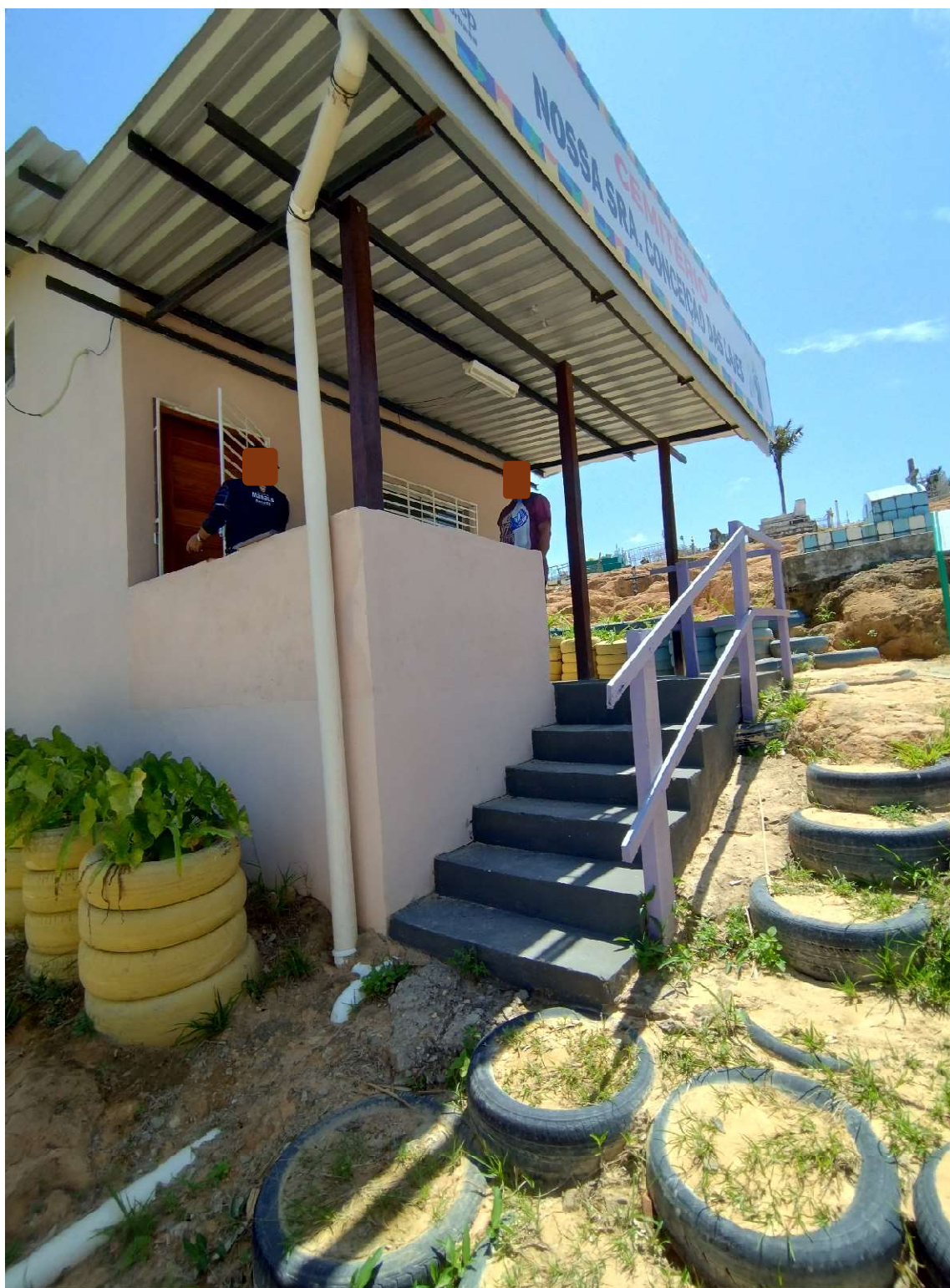
Imagem 70 Prédio da administração do Cemitério Nossa Senhora da Conceição das Lajes. Acervo pessoal. 10/10/2023
