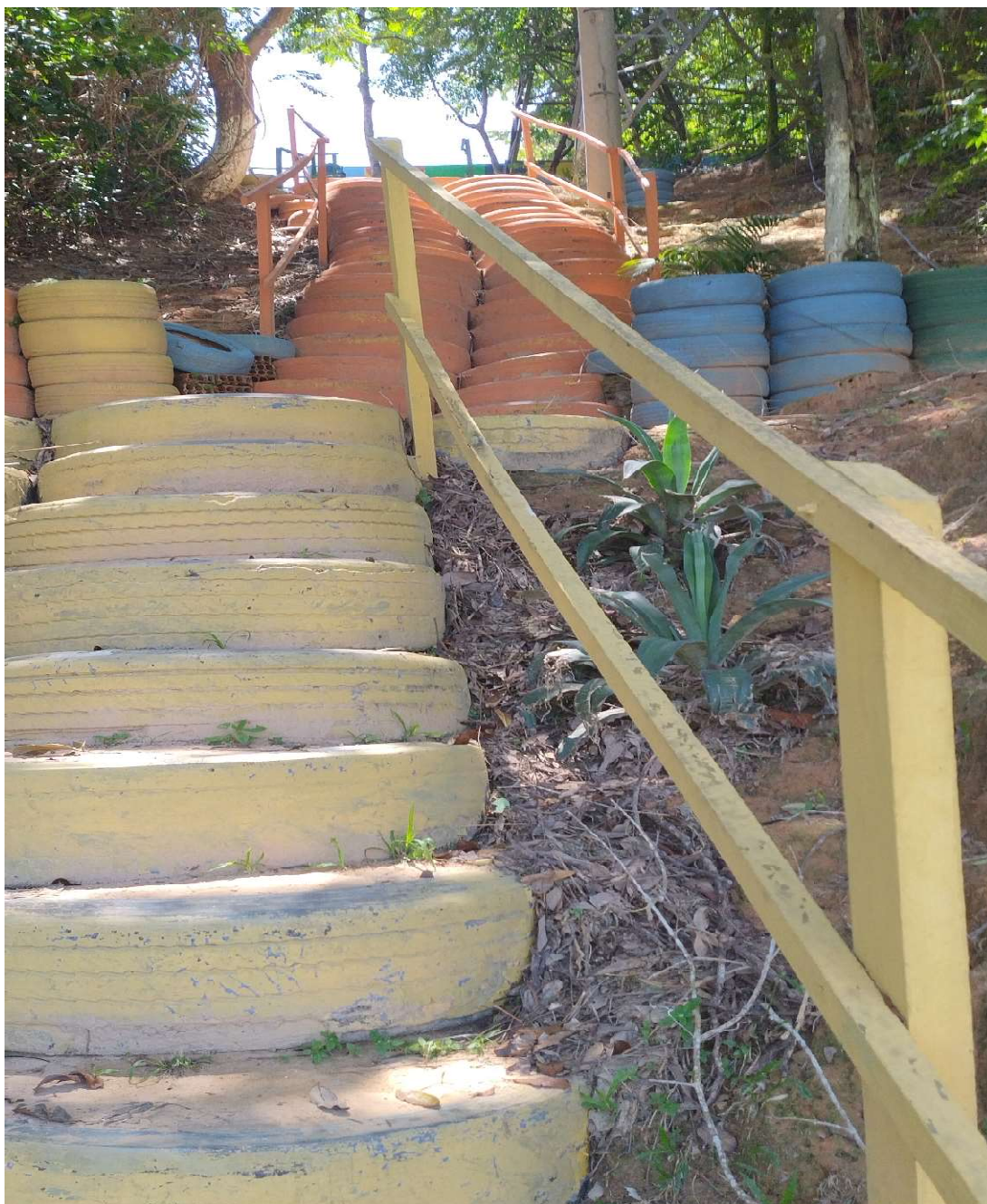
Figura 23: Acervo pessoal. Escadaria de acesso ao cemitério Nossa Senhora da Conceição das Lajes . Em 10.10.2023
