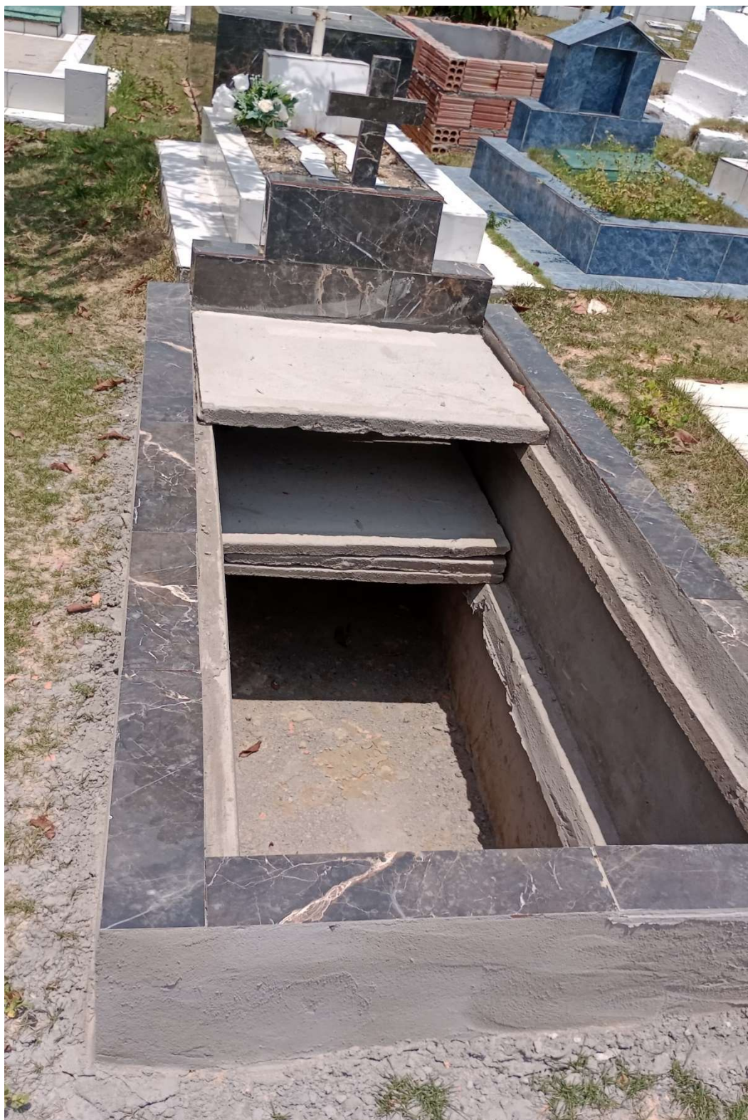
Imagem 17 Construção das câmaras internas do túmulo. Acervo pessoal. 10/10/2023
