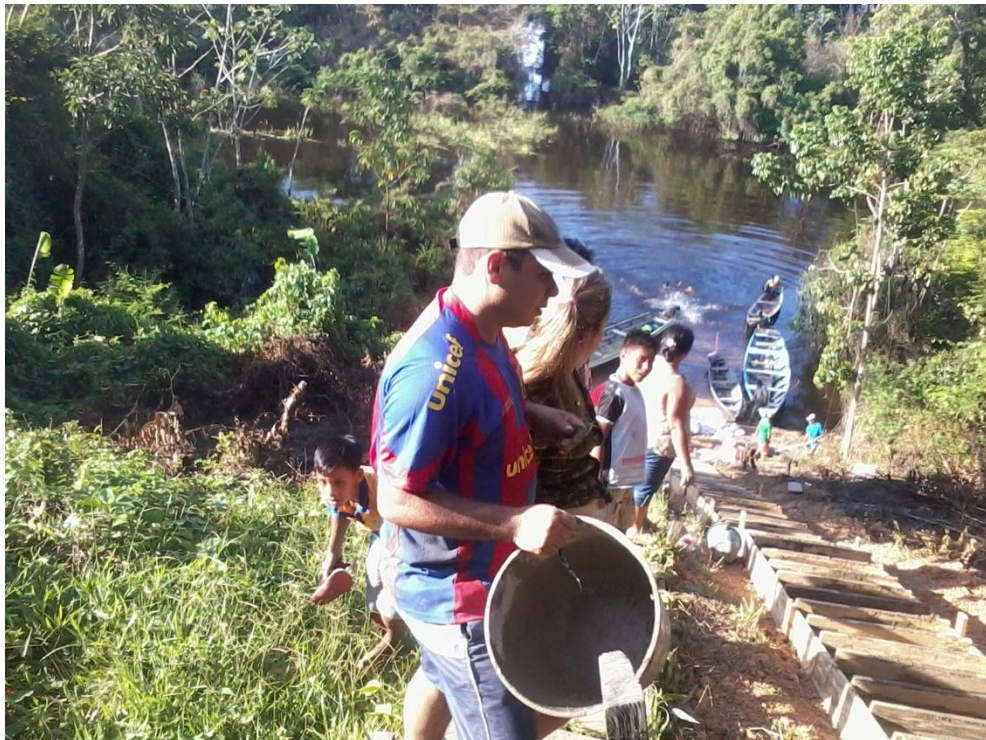
Imagem 22: Professores na construção da escada que dá acesso a escola
