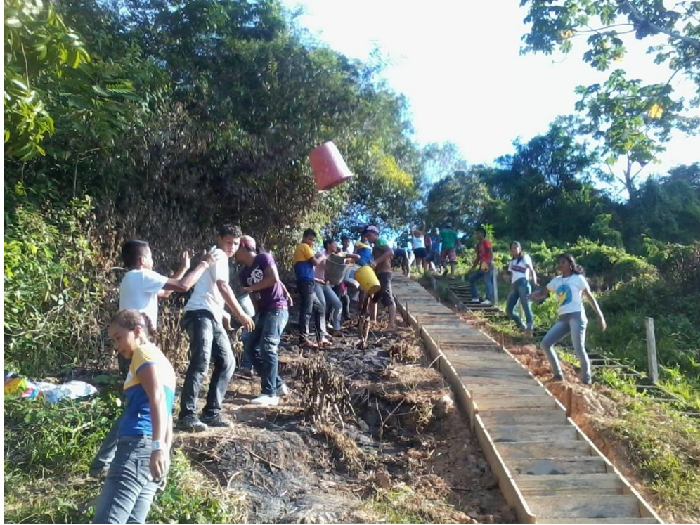
Imagem 21: Construção da escada que dá acesso a escola
