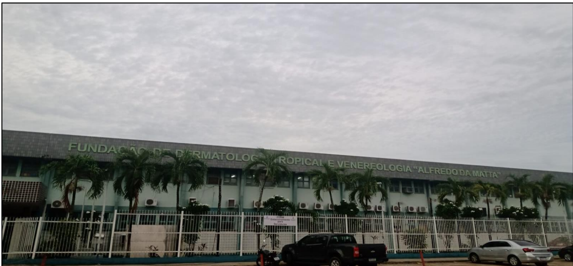
Figura 3 - Fachada da Fundação Hospitalar Alfredo da Matta, 2023
